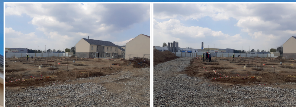
Démarrage des travaux de la caserne
